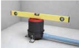
Die Vorteile des neuen Duschablaufs zeigen sich bereits beim Einbau: Stabile Befestigung durch Schrauben an der Rohbetondecke mit integrierten Schallschutz-„Patscherln“. Weiter kann der Grundkörper über Stellwinkel in der Höhe justiert werden, um ein Gefälle zum Ablaufrohr zu erzeugen.
