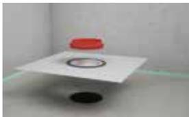
Anschließend wird die Abdichtmanschette, bestehend aus einem flexiblen Dichtvlies und integrierten Dichtlippen, eingesetzt und mit der Alternativabdichtung sicher verbunden.
